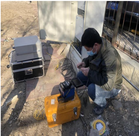
分布式光纤引线熔接
