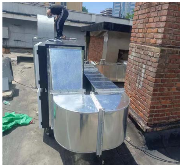
油烟净化器设备安装
